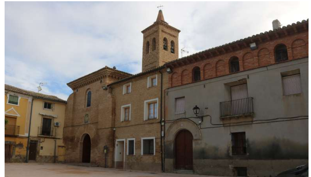
Fachada de la iglesia de Bárboles y su entorno.
