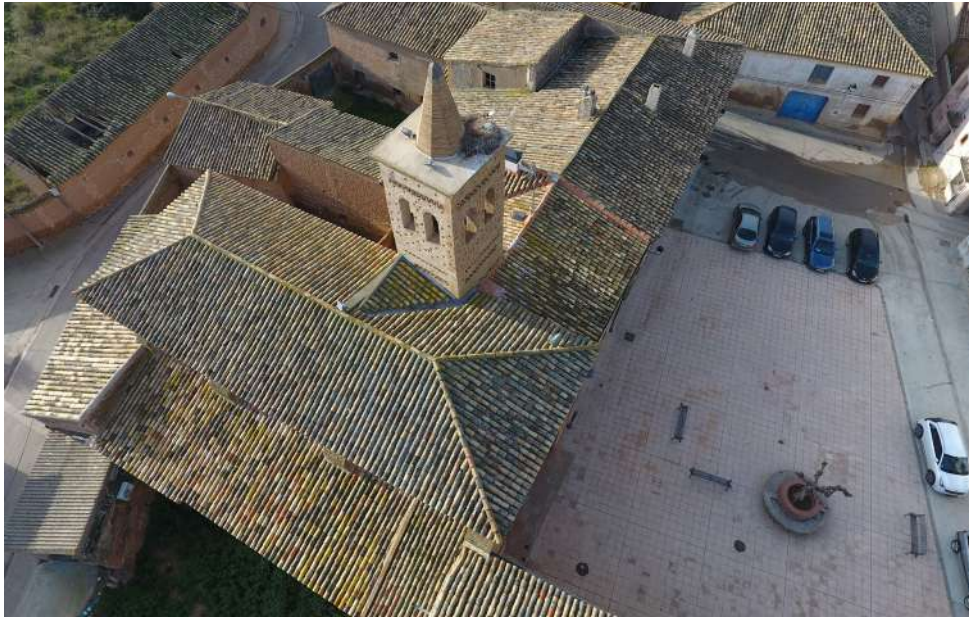
Iglesia de Bárboles, fotografía mediante dron.
