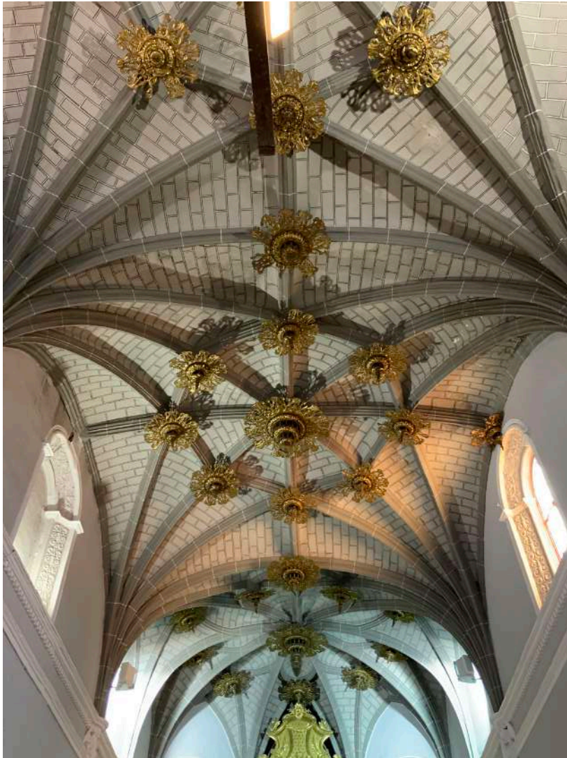
Bóveda nervada de la nave central.
