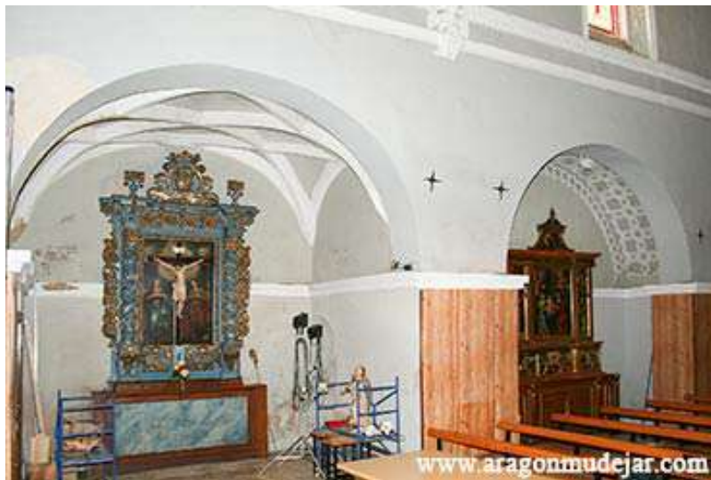
Estado de la Iglesia previo a la reforma
