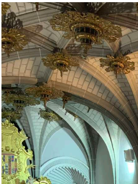
Detalle de los nervios de la bóveda, los frisos, y las decoraciones de conchas en la nave central de la iglesia
